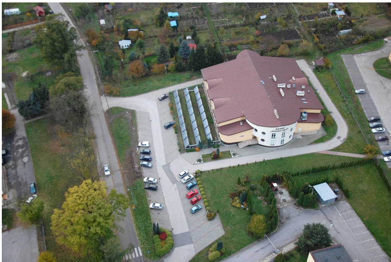
Rysunek 6 Widok z lotu ptaka lokalizacji planowanej inwestycji
